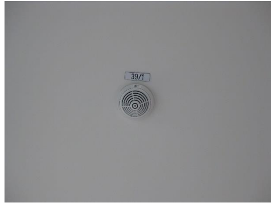
Bild 26 Kennzeichnung eines Brandmelders im Vergleich. Einfacher Aufkleber auf dem Sockel des Brandmelders versus separate große gravierte Platte. Den einfachen Aufkleber kann man kaum noch erkennen. Im Zweifelsfall separate große Platte und große Schrift verwenden.
