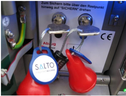
Bild 7 Überlange Schlüsselschäfte müssen eingekürzt und neu gebohrt werden, sodass ausreichend Platz zwischen Schlüssel und Umstellschloss vorhanden ist. Das Bohrloch auf der linken Seite des Schlüssels bewirkt, dass der Schlüssel auf der Stellung „Sichern“ verbleibt.
