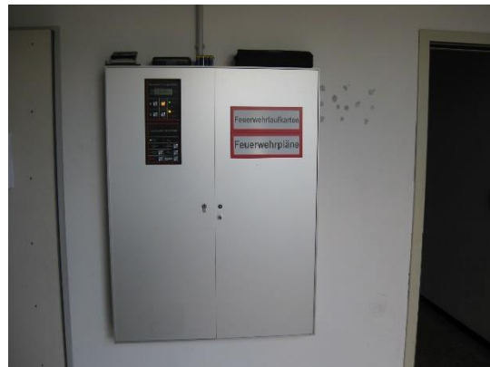
Bild 16 Erstinformationsstelle in Alu-Ausführung und ordnungsgemäßer Kennzeichnung der Feuerwehrlaufkarten und des Feuerwehrplanes mit Schildern nach DIN 4066 D1.
