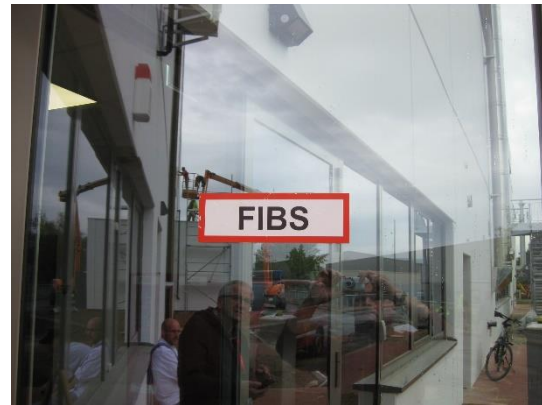
Bild 10 Bei Neuanlagen wird zur Kennzeichnung des Feuerwehrehauptzuganges zur Erstinformationsstelle das Hinweisschild nach DIN 4066 D1 mit der Aufschrift „FIBS“ verwendet. Bestandsanlagen müssen sukzessiv umgekennzeichnet werden.
