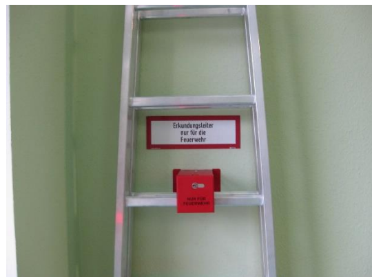
Bild 30 Ordnungsgemäße Kennzeichnung nach DIN 4066 D1 und Sicherung mit einem Profilhalbzylinder (Gebäudeschließung).
