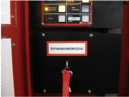
Bild 25 Kennzeichnung eines Werkzeuges/Schlüssels nach DIN 4066 D1, jedoch, abweichend von den Normmaßen, in den Abmessungen stark reduziert.
