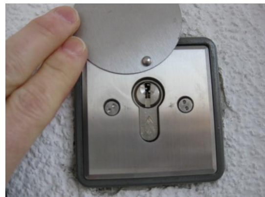
Bild 12 „FSE-Typ Profilhalbzylinder“ im eingebauten Zustand.
