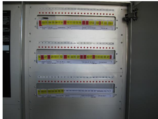
Bild 20 Im rechten Teil der Erstinformationsstelle befinden sich die Feuerwehrlaufkarten. Da mehr als 50 Feuerwehrlaufkarten vorhanden sind, befindet sich oberhalb der Feuerwehrlaufkarten eine Anzeige (rote LEDs).
